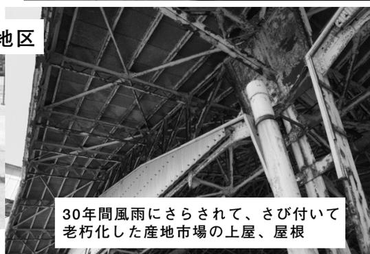
30年間風雨にさらされて、さび付いて老朽化した産地市場の上屋、屋根
