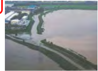
図：洪水被害の事例 (国土交通省中部地方整備局提供)
