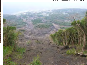
◎2013年台風25号の被害 (伊豆大島)
