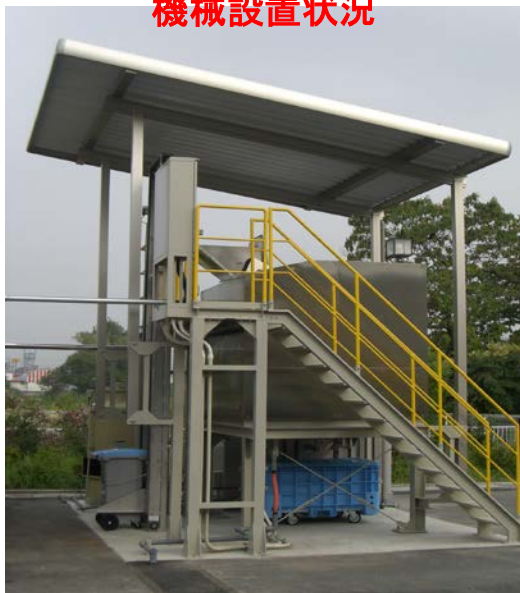
機械設置状況
