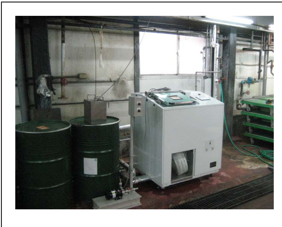
機械設置状況
