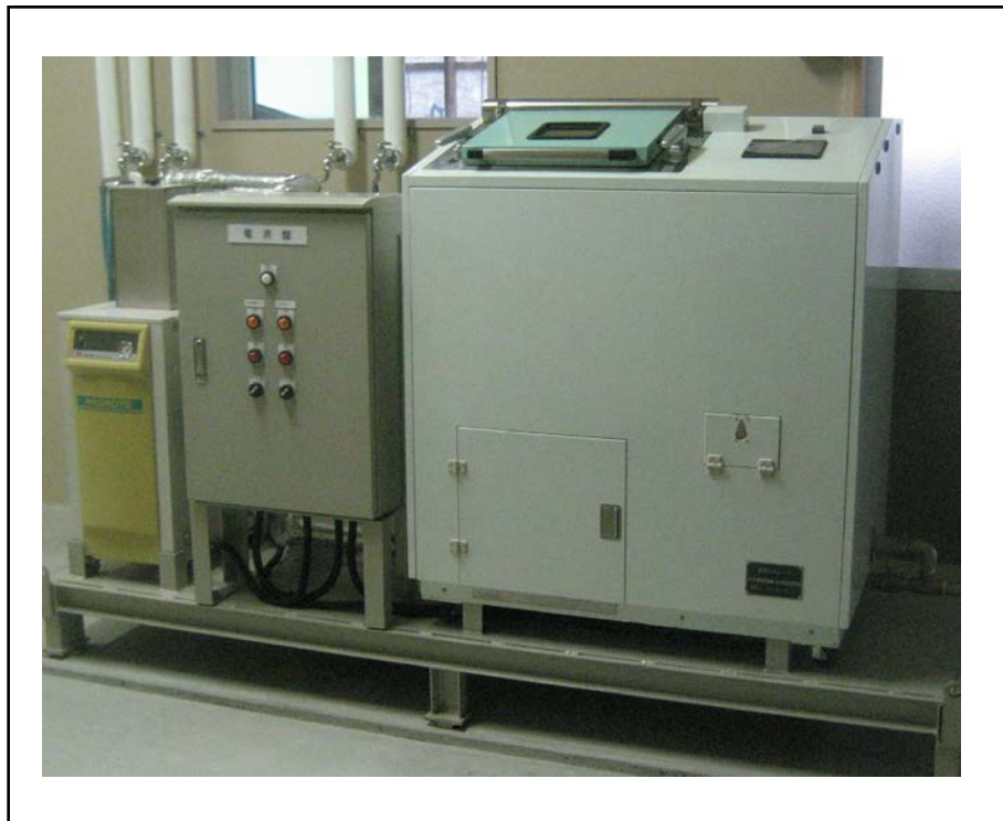
機械設置状況
