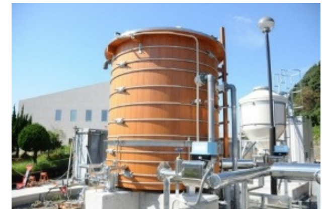
【FSC認証材を使用した受水槽】
