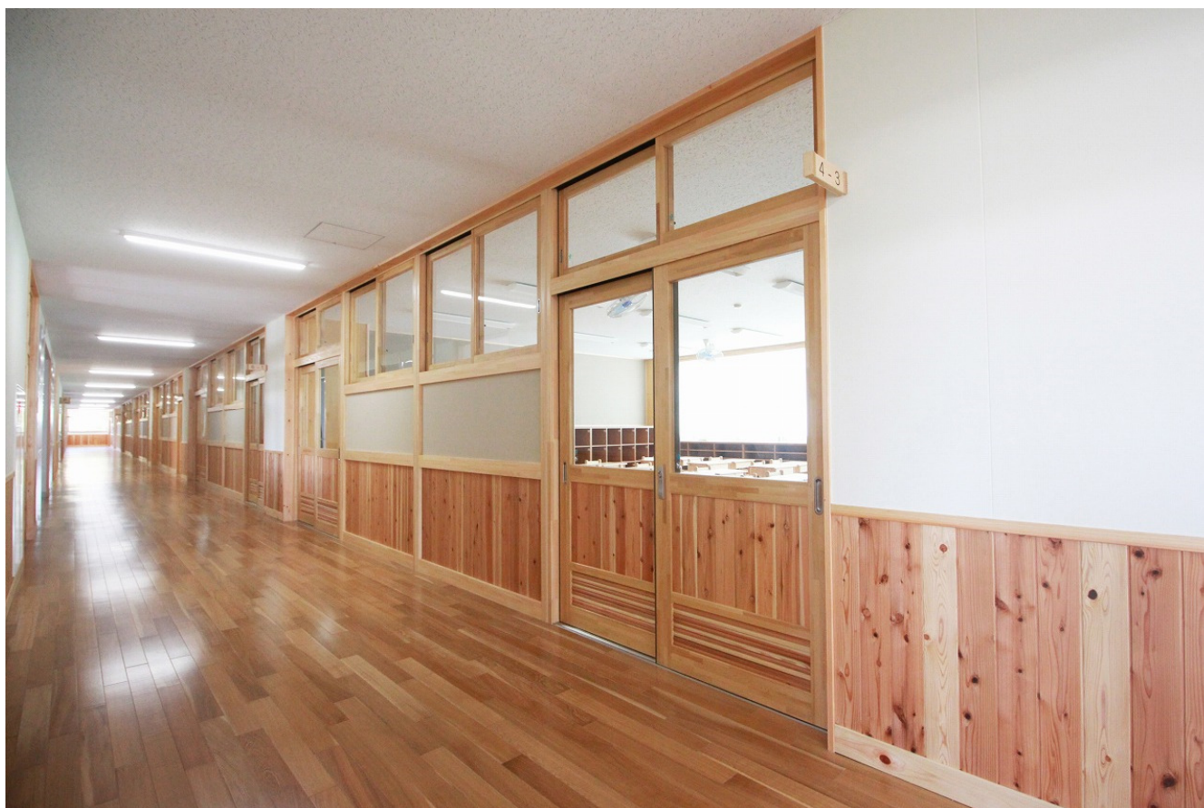
【間仕切りにFSC認証材（スギ・ヒノキ）を使用】
