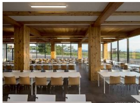
羽黒高校(山形県) 国内初の木造3階建て 準耐火校舎(2017年竣工)
