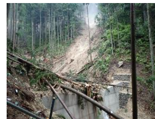
治山ダムが溪流の勾配を緩やかにしてため流木流出を抑止した事例【福岡県八女市】
