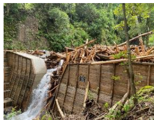
流木捕捉式治山ダムが流木及び土石を捕捉した事例【熊本県球磨村】
