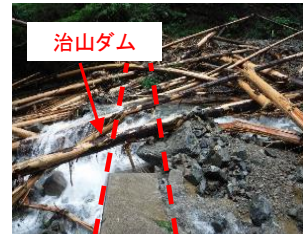
治山ダムが溪流の勾配を緩やかにしてため流木流出を抑止した事例【福岡県八女市】
