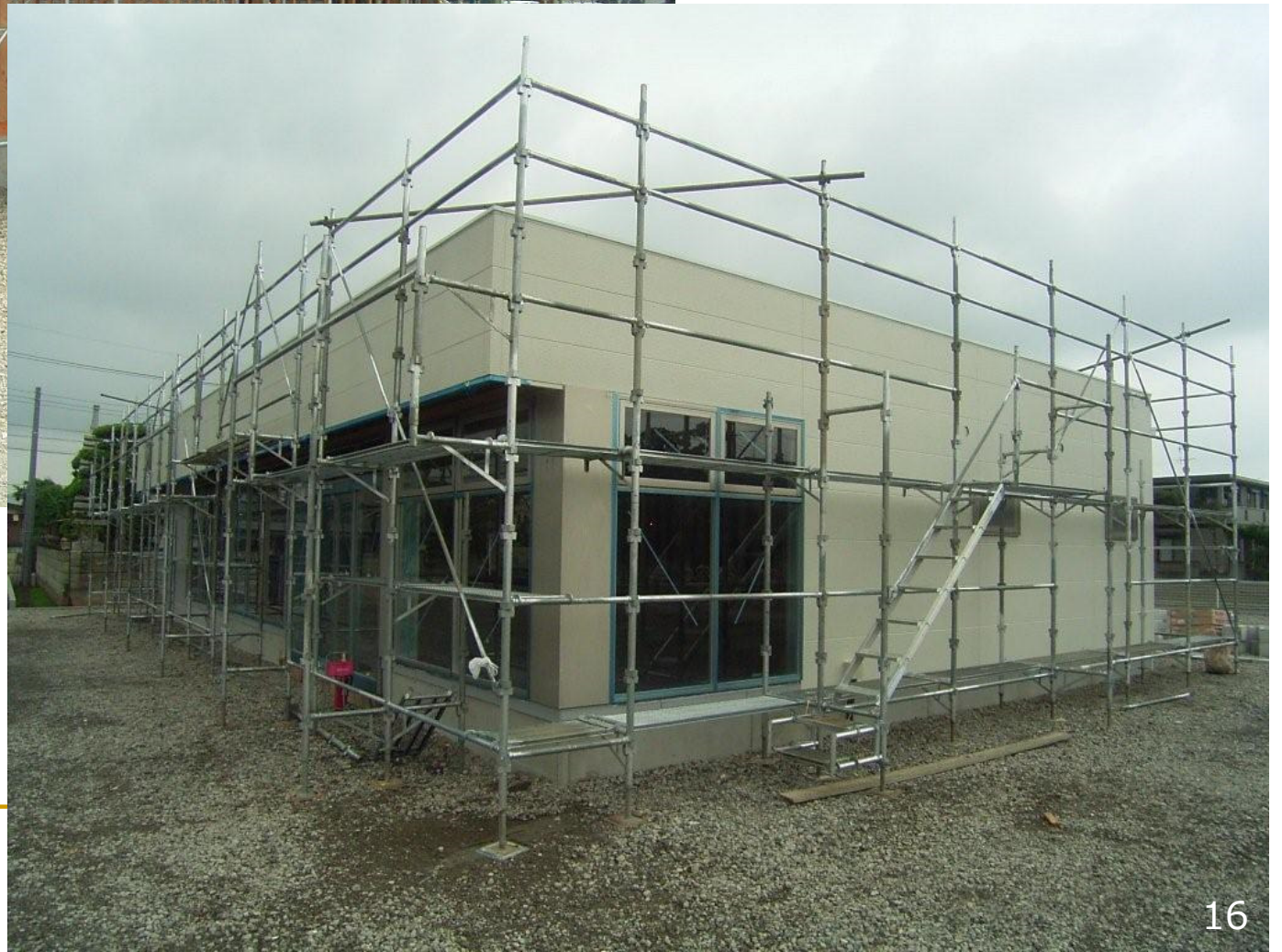
コンビニエンスストアの木造店舗の建築の様子 (ミニストップ社提供)
