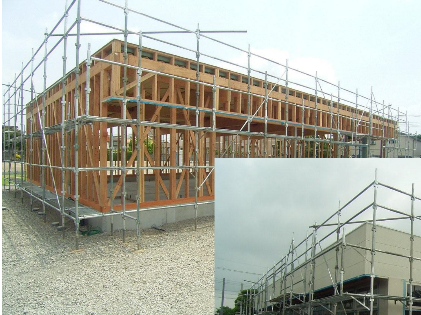
コンビニエンスストアの木造店舗の建築の様子 (ミニストップ社提供)
