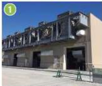
ガスタービン発電機建屋
