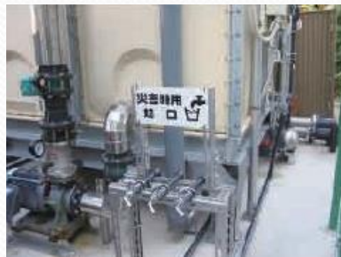
四日市社会保険病院様 近隣の自治会と「災害時における井戸の使用に関する防災協定」を締結。(2007年1月)
