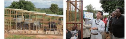
運河からの水を浄化するために設置された「緩速ろ過装置」 【緩速ろ過装置】の仕組みや使い方を現地の方に説明
