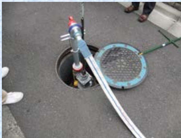
排水栓とスタンドパイプ
