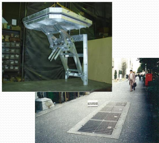
③ 換気口と浸水防止機
