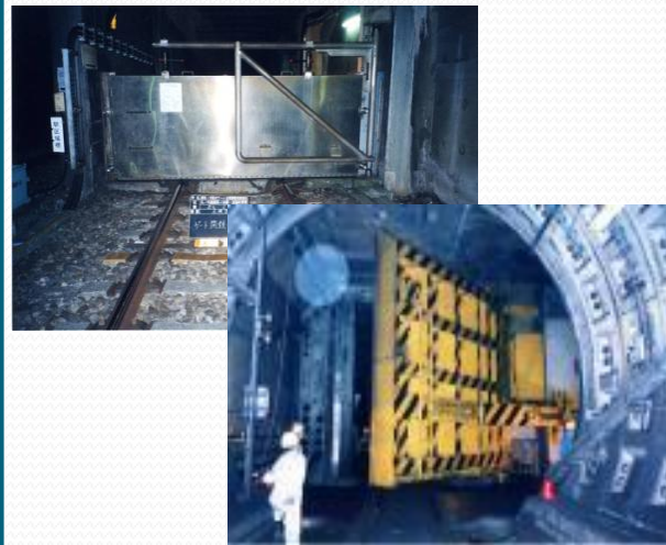
② 防水ゲート
