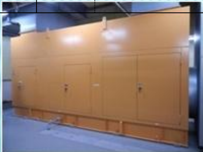
非常用発電機
