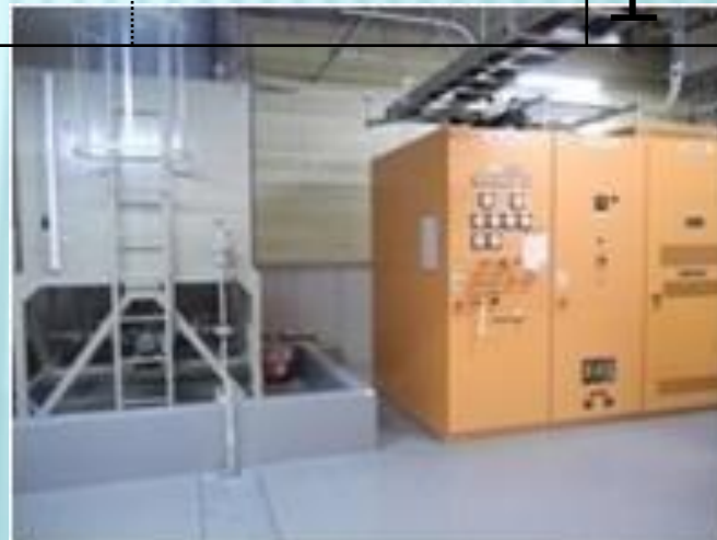
燃料タンク(一部)
