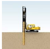
重機により保存処理木材を圧入
