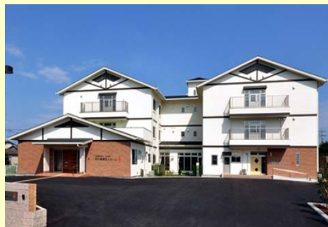
岡山県玉野市の特別養護老人ホーム (国内最大級の在来工法による木造耐火建築物)
