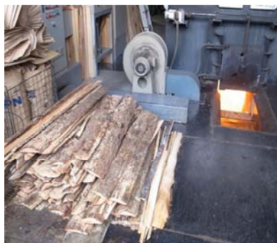
チップボイラー(右奥)と燃料となる工場残材(手前)
