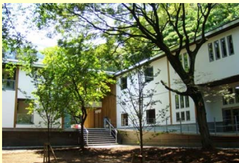
東京大学の教育研究支援施設 (一般流通材を用いて在来工法により建築)
