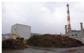
石炭火力発電所の未利用間伐材等受入れ施設
