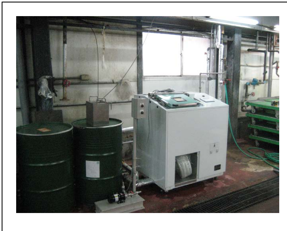
機械設置状況
