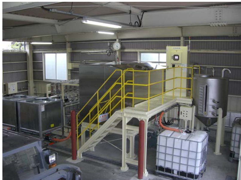
機械設置状況
