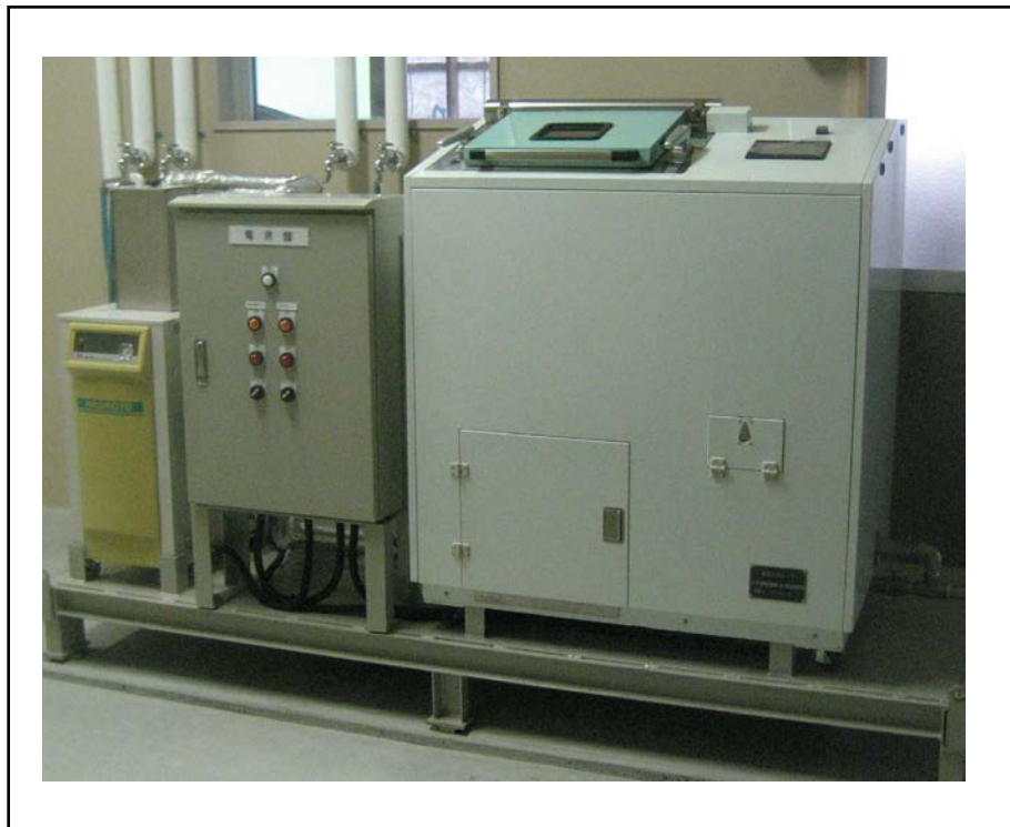
機械設置状況
