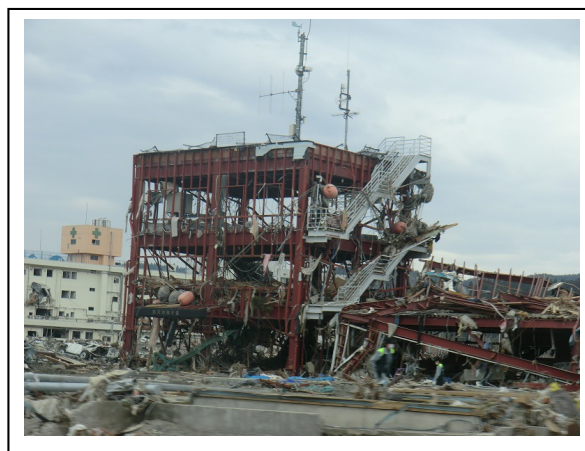
図 1. 南三陸町防災センター
