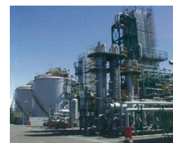
LNGプラント
