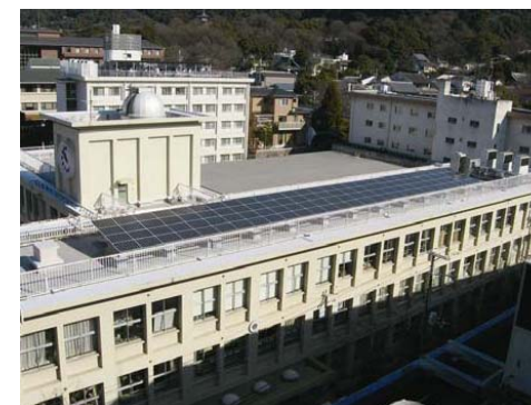
学校への太陽光パネルの設置(出典:環境省HP)
