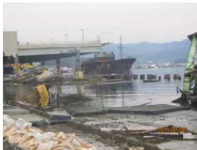
気仙沼市 破壊され冠水した魚市場
