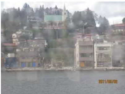
陥没した気仙沼のウォーターフロント
