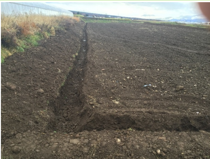
明渠で排水対策
